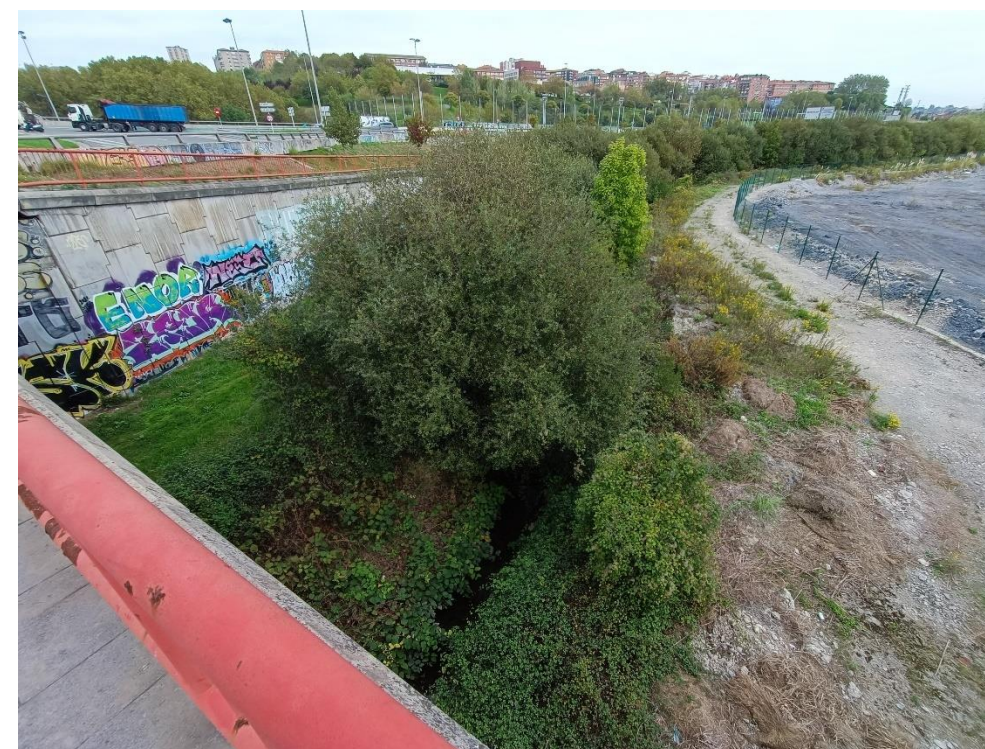
Figura 13: Estado actual del cauce del río Ballonti en una de las zonas en mejores condiciones. Fuente: elaboración propia.
